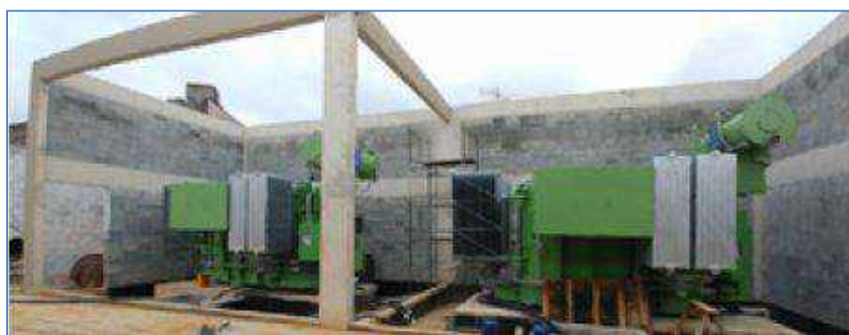
Figura 16 – Disposição dos transformadores dentro da barreira acústica
