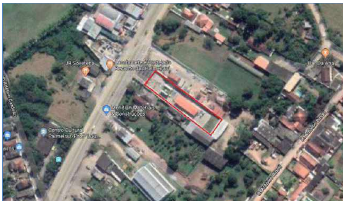
Figura 21 – Localização da subestação de Amazonas (Suzano – SP)
