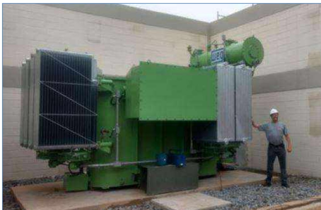
Figura 22 – Transformador 15/20 MVA
