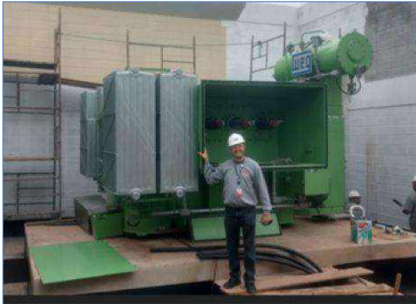
Figura 19 – Transformador 7,5/9,375MVA
