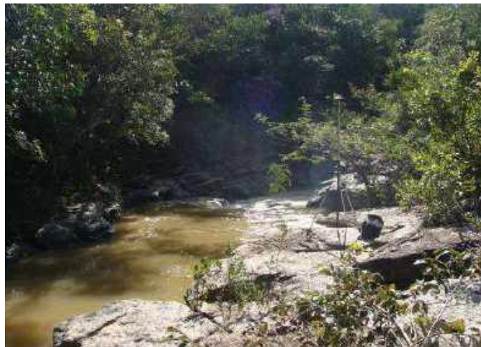
Figura 17: Local avaliado para a implantação da casa de máquinas e bacia de dissipação
